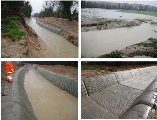
Sistemi di protezione spondale e impermeabilizzazione in corsi d'acqua, casse di espansione e vasche di laminazione
