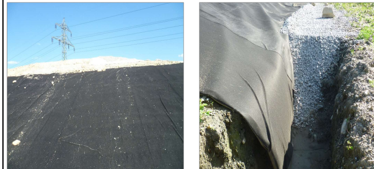
Trincea di ancoraggio della geomembrana al piede; la ghiaia ha un effetto stabilizzante nei confronti dell'erosione e concorre alla realizzazione della copertura della diga
