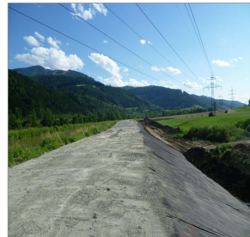
Preparazione del sottofondo
